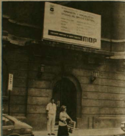
Arreglando la fachada
