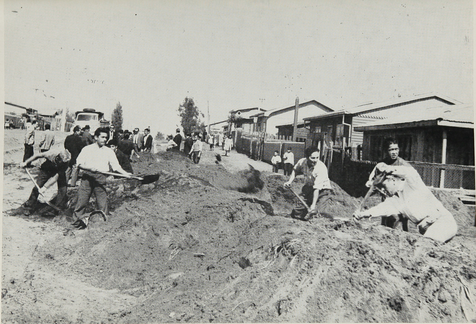
Participaron en la Operación Invierno los propios pobladores, que combinaron su trabajo efectivo con los aportes del Estado en financiamiento, máquinas y asesoría.
