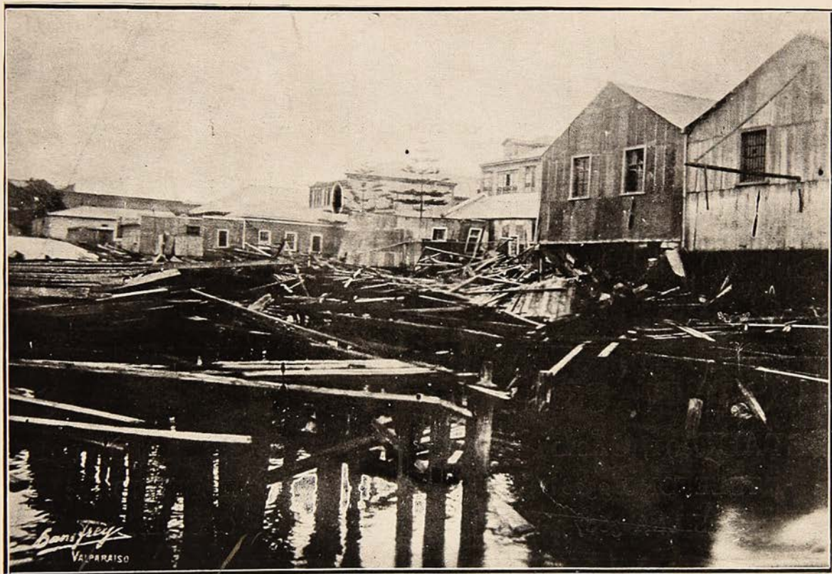
Bodegas comerciales, cerca del Muelle, destruidas completamente.
