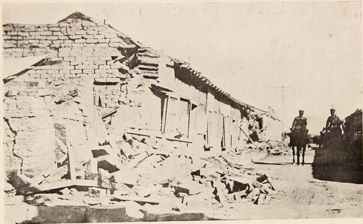
La calle Atacama esquina con la de Rancagua quedó convertida en un montón de escombros.
