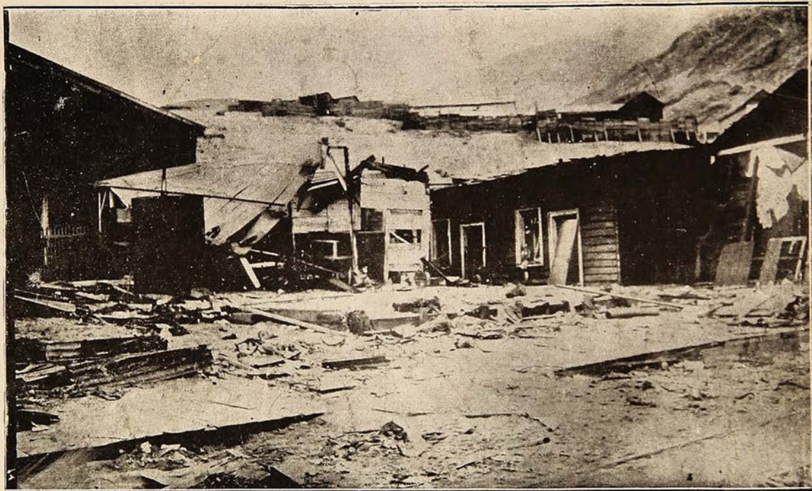
El Cuartel de Bomberos completamente destruido.
