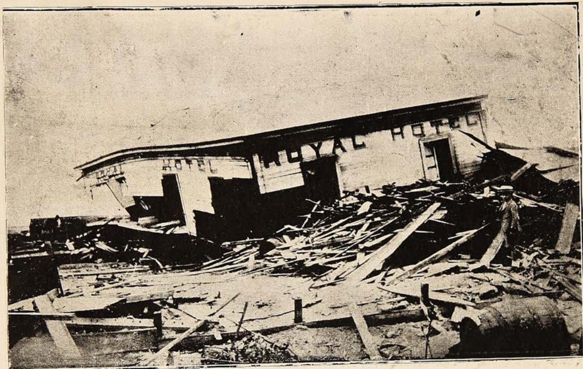
El Hotel Royal, completamente destruido con la fuerza del maremoto.
