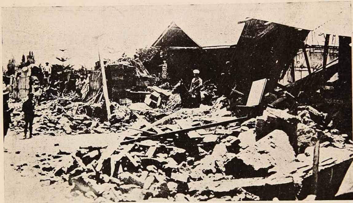
El Cuartel de Policía de Copiapó después del terremoto.
