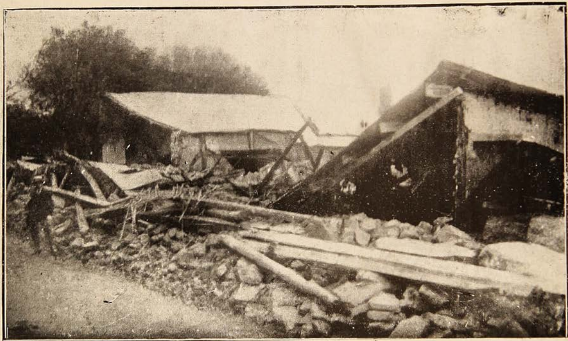
Destrozos causados por el terremoto en una de las calles más centrales de Vallenar.
