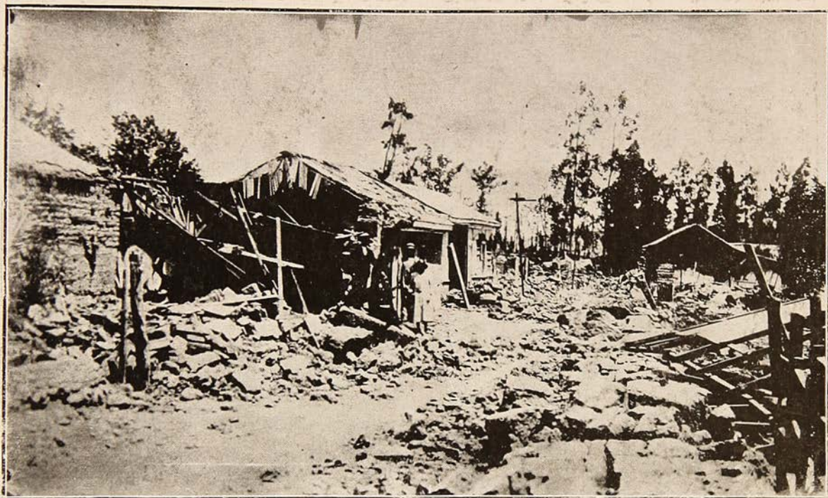
Aspecto de la calle Chañareillo después de la catástrofe.
