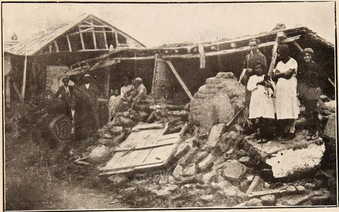
Estado en que quedaron los mejores edificios de la ciudad.
