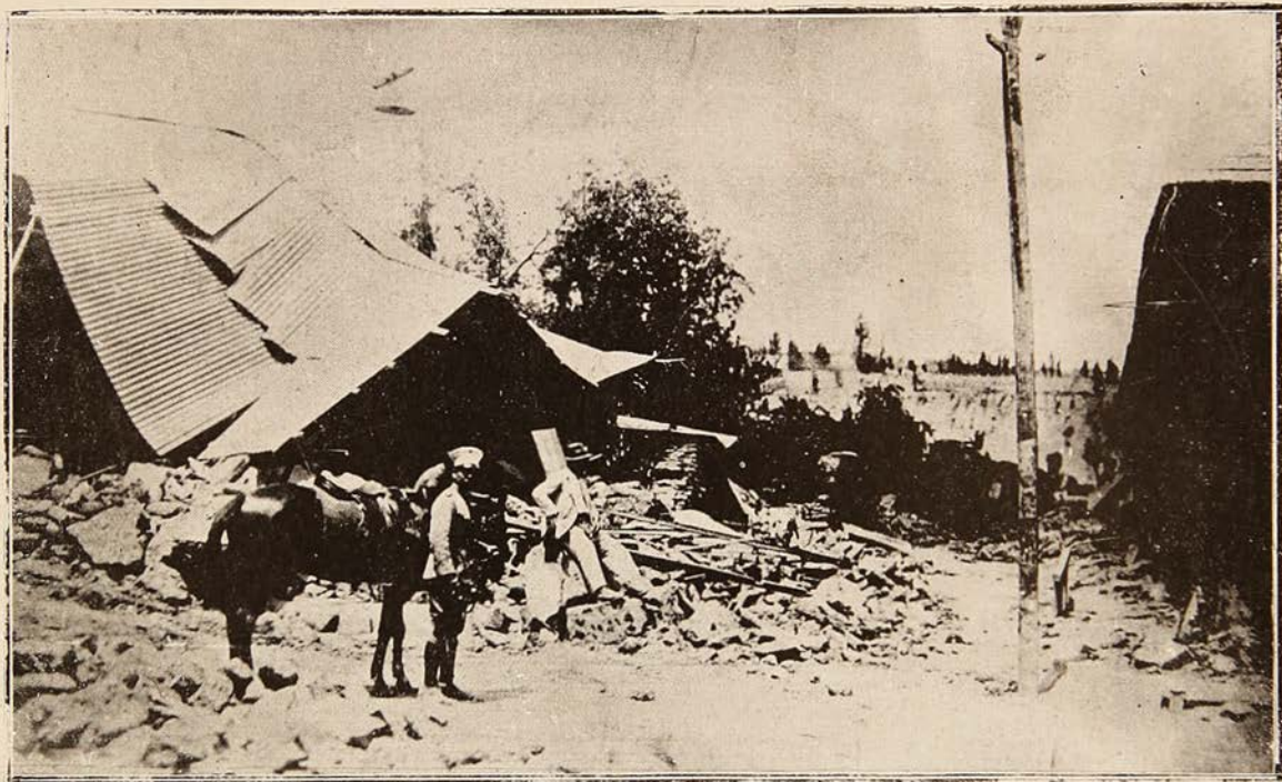
El Cuartel de Policía, completamente destruido.
