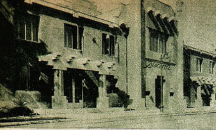
Fachada de la Piscina Escolar.
